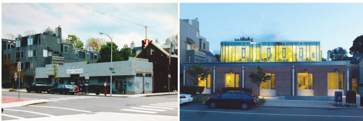
Fig. 4: Broadway 421, Boston (MA): bâtiment de la première swissnex avant et après les travaux de transformation
